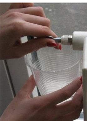
Schritt 4: Entlüftungsschlüssel am Entlüftungsventil ansetzen und dann **langsam nach links drehen** bis es leicht zischt und Luft entweicht.
