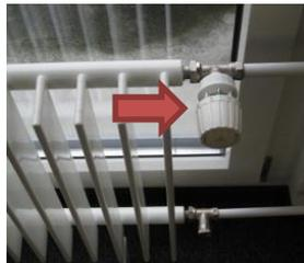
Schritt 1: Heizkörper via Ventil ganz aufdrehen und 5 Minuten abwarten.
