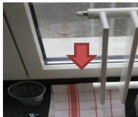
Schritt 2: Handtuch unter Entlüftungsventil legen.
